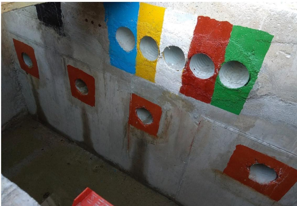
**Fotografía 1.** Ejemplo de tubos de salida de drenajes del fondo del vaso **Fuente:** Elaboración propia
