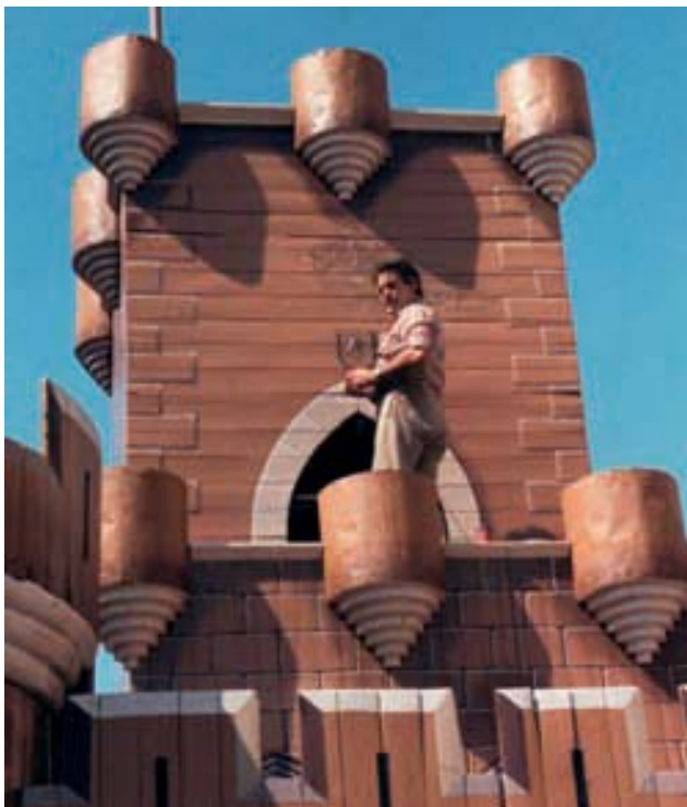
Eleuterio Molina durant la restauració del castell. Dècada dels anys 80
