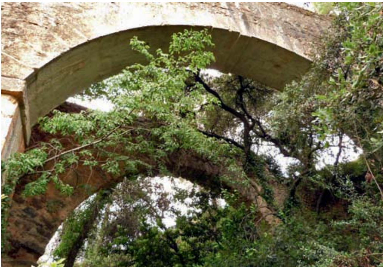
Foto 16. El doble aqüeducte de la Frontera que permet el pas d'aigua de la font de la Rambleta fins al dipòsit/partidor de Bocairent
