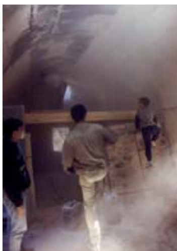
Endreçant la volta de silleria del refugi de Castelló. Any 1994
